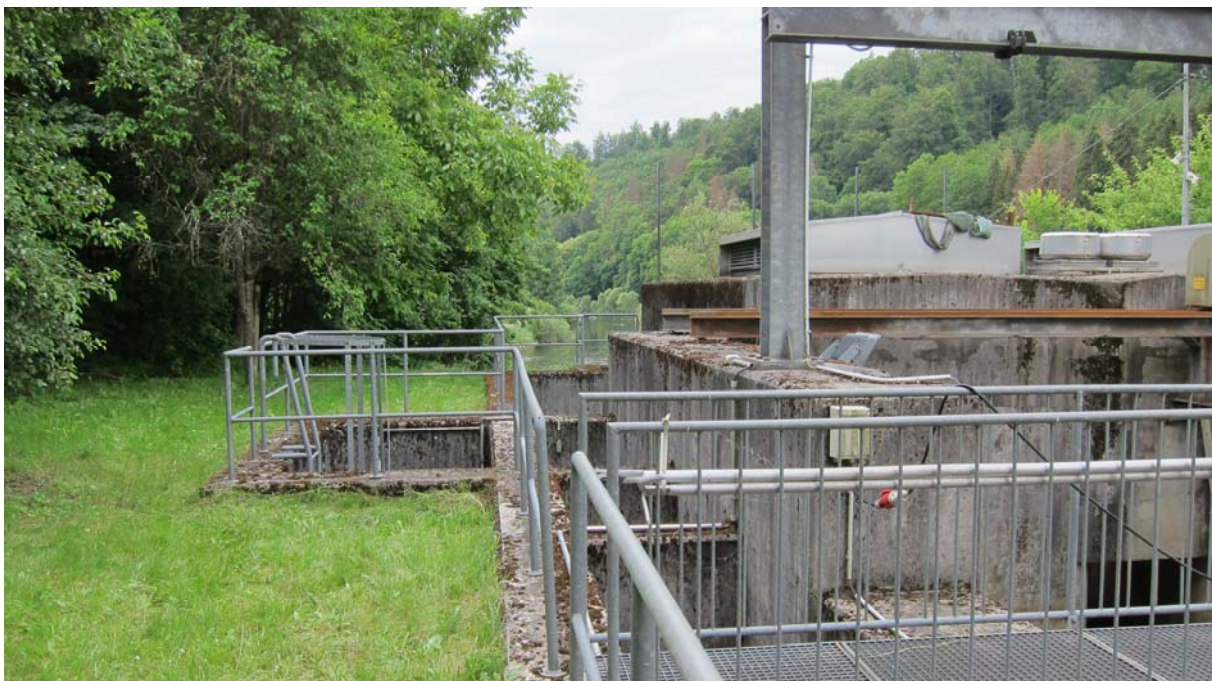
Blick auf Gesamtanlage nach Unterwasser (mittig Fischpass, linksseitig vorspringend Schieberschacht, im Vordergrund der oberhalb der Rechenanlage querende Gitterroststeg)
