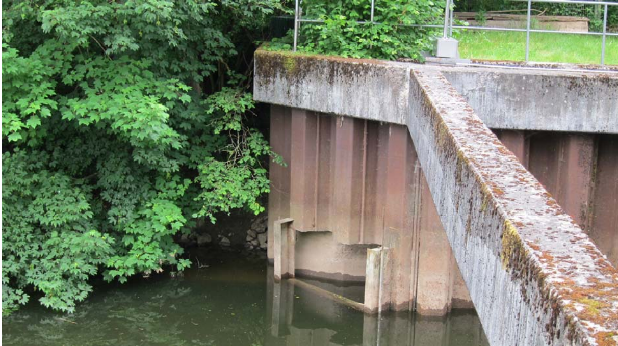
Blick von Oberwasser auf Einlaufbereich des Fischpasses
