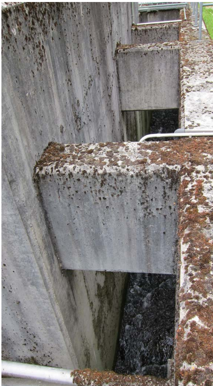
Blick auf Fischpass, gegen Fließrichtung
