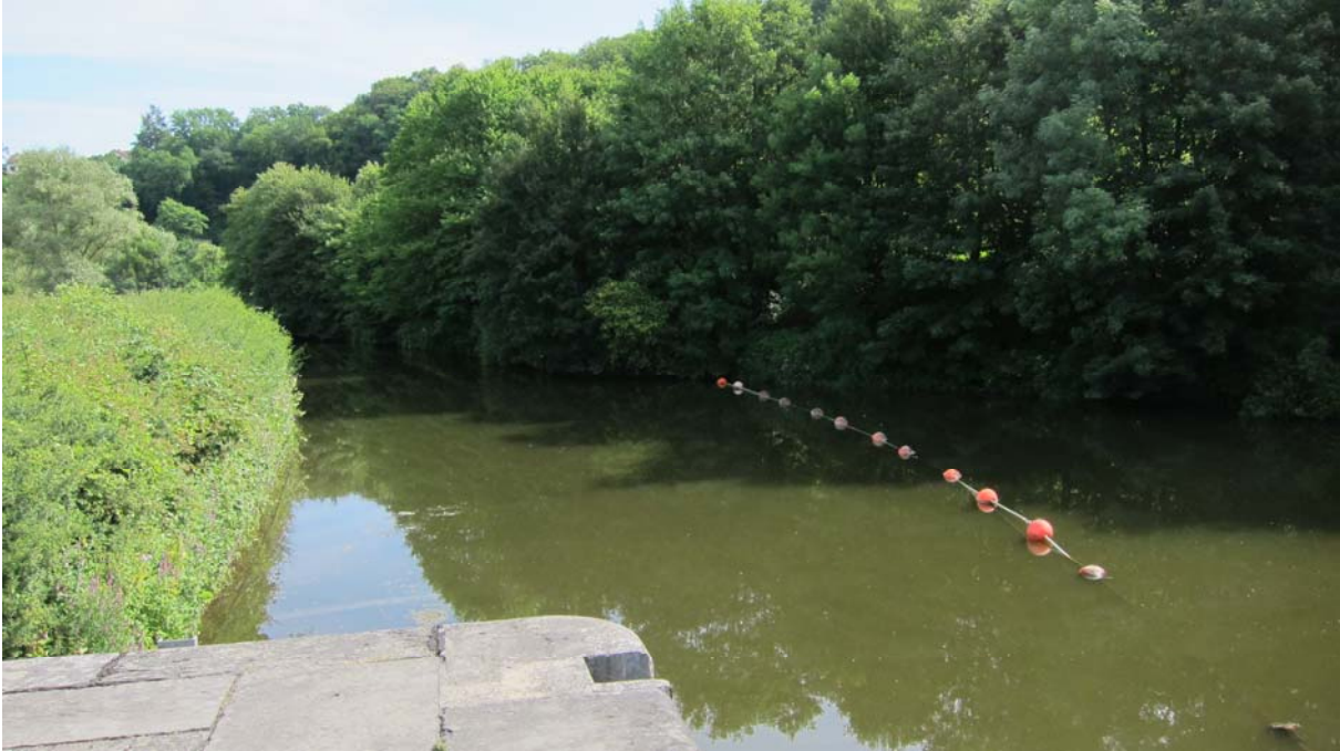
Blick vom Schleusenkanal ins Oberwasser
