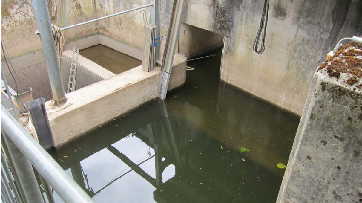
Vorfeld des rechten Einlaufrechens (eingestaut), linkes Rechenvorfeld abgelassen (im Hintergrund), Leerschusskanal mittig
