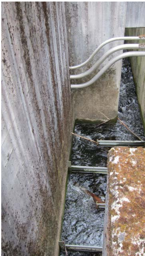
Fischpass-Bereich mit größerer Lichtweite, Blick gegen Fließrichtung
