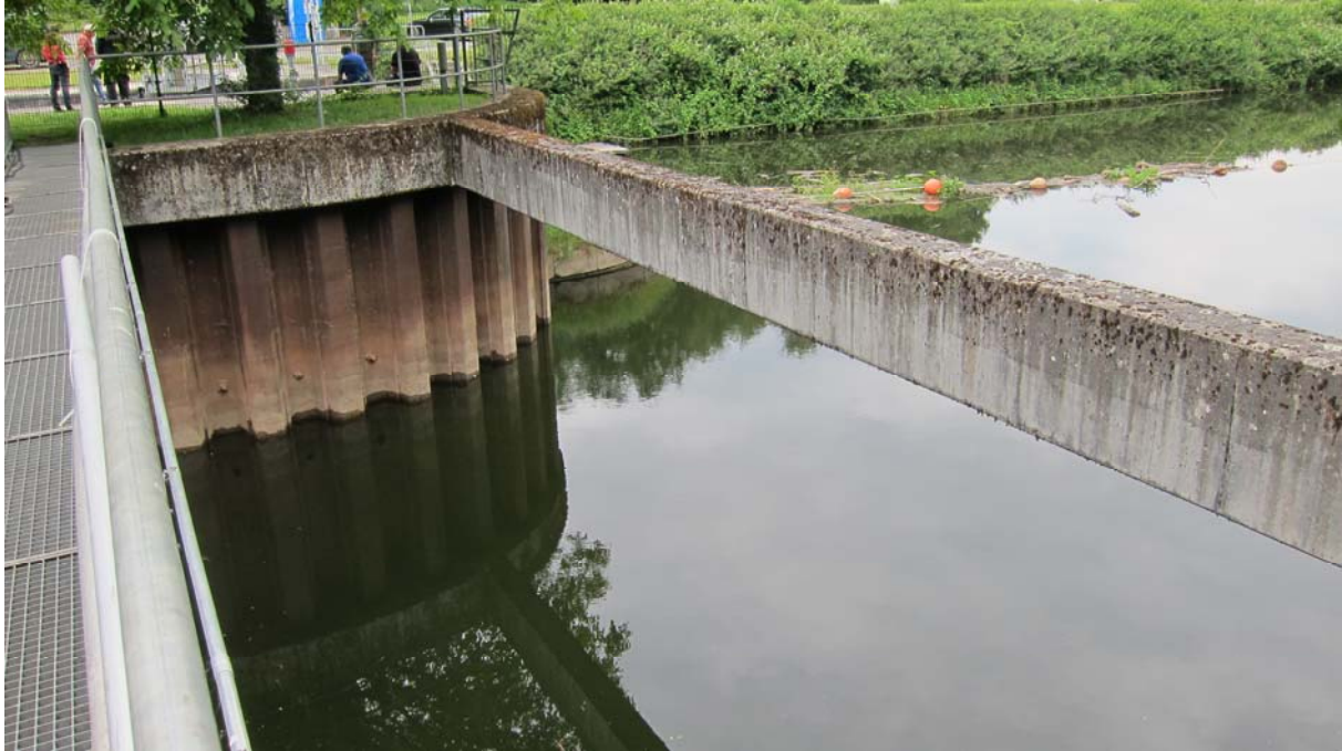
Blick über Zulaufbereich Turbinenkanal zur Bojenkette (Abtrenng. Schleusenkanal)
