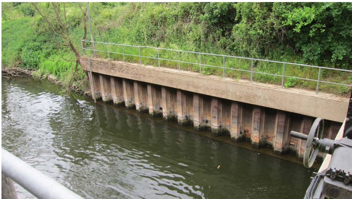
Blick auf rechtsseitige Uferbefestigung, unterhalb Auslauf Turbinenkanal
