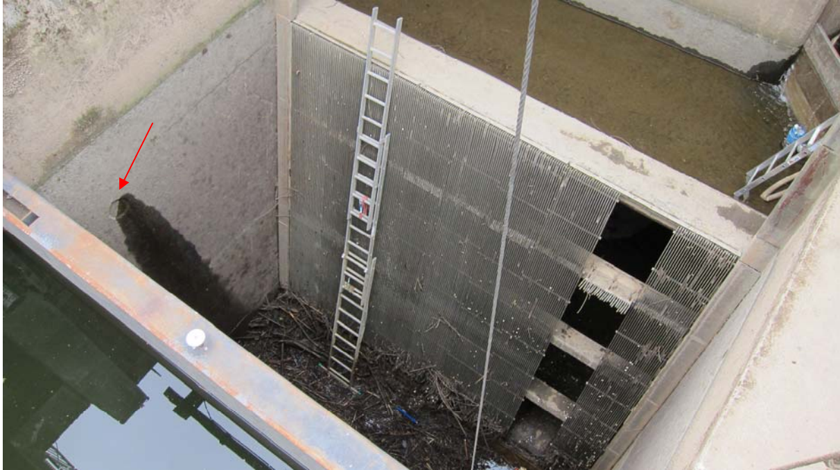
Blick auf (beim Bau des Borstenpasses) mitverlegtes Aalrohr in der linken Trennwand zwischen Rechenvorfeld und Fischpass (s. Pfeil-Markierung)
